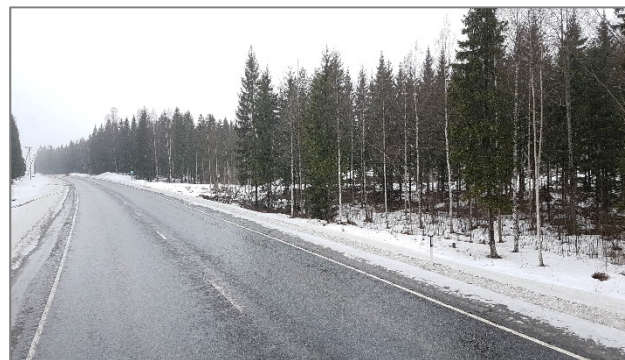
Kuva 6.21. Valokuva 17.3.2019 risteyksen kohdalta.
